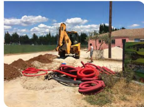
Arrivée des réseaux d'eau pour l'arrosage et d'électricité pour l'éclairage.
