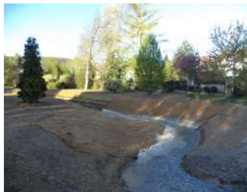
Figure 3 : Exemple de profil dissymétrique avec adoucissement des pentes de berge et création de risberme.
