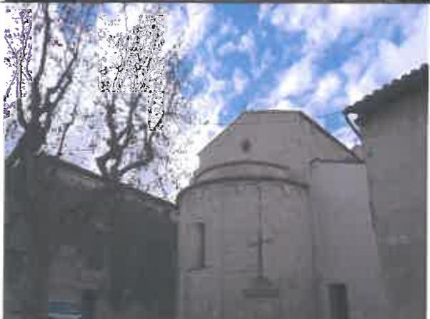
Photo 2 : L'entrée de l'église est sur une petite ruelle débouchant sur la place de l'église et représentative de l'étroite insertion du bâtiment dans le tissu urbain.
